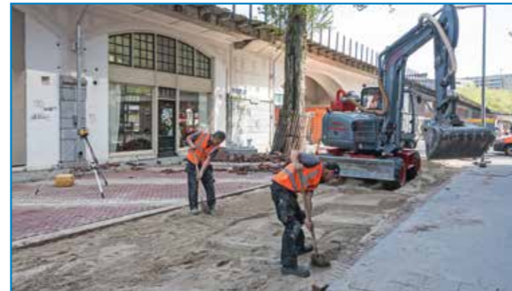
Vervanging van het riool
